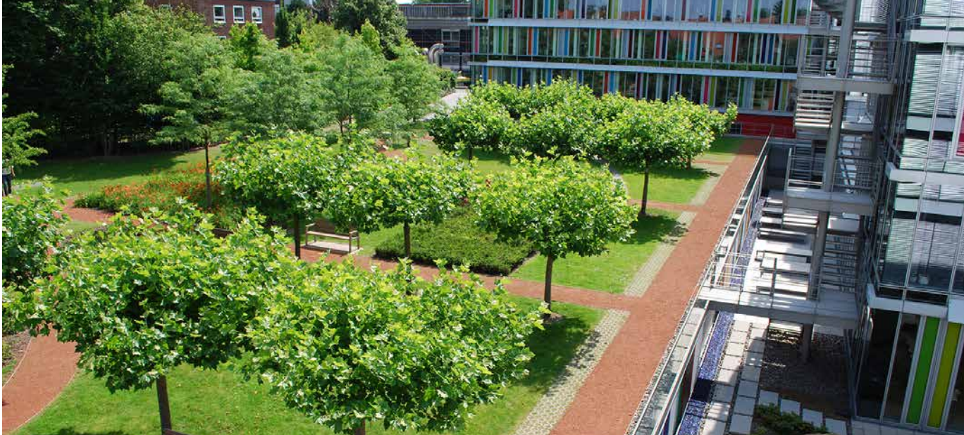
Unten parken Autos, darüber wachsen Bäume: Die LVM in Münster hat sich auf ihrer Tiefgarage von der Marcel Nadorf GmbH einen Park anlegen lassen. Foto: Nadorf GmbH
